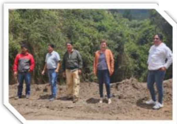
Comunidad San José Alto Construcción del estadio
