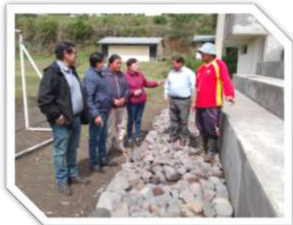
San Pablito de Agualongo Construcción de la Tribuna
