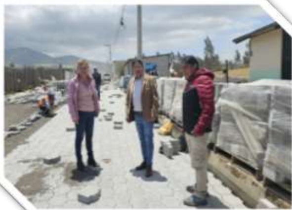
Barrio 18 de septiembre Fiscalización Adoquinado
