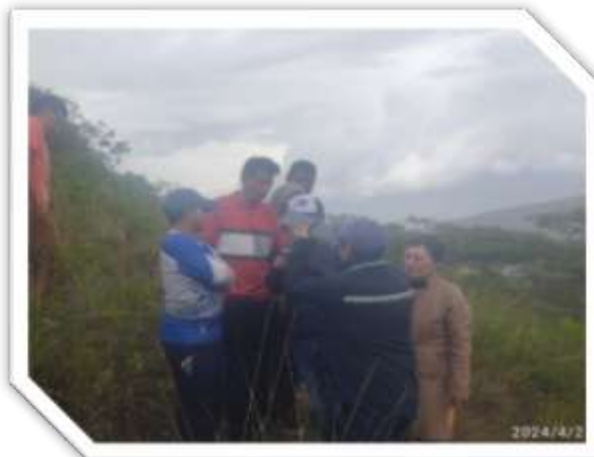
Parroquia Malchingui Fiscalización de las piscinas de oxidación y su reubicación
