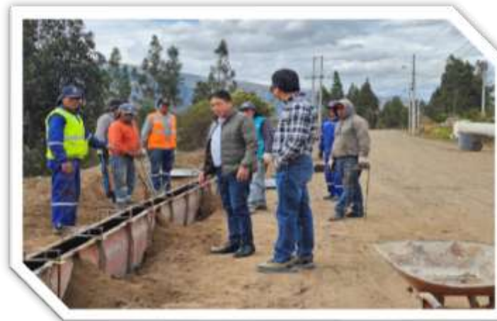
Comunidad Guallaro Grande Construcción de Bordillos
