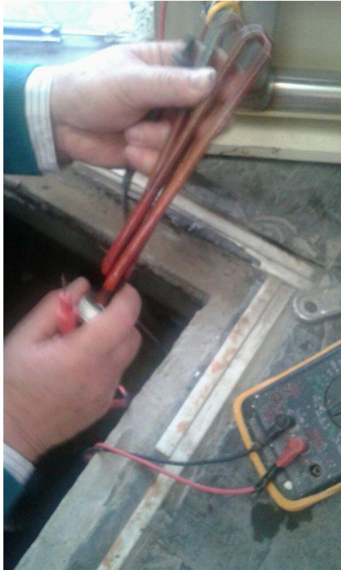
Mantenimiento de piscina, con el reemplazo de dos calentadores.
